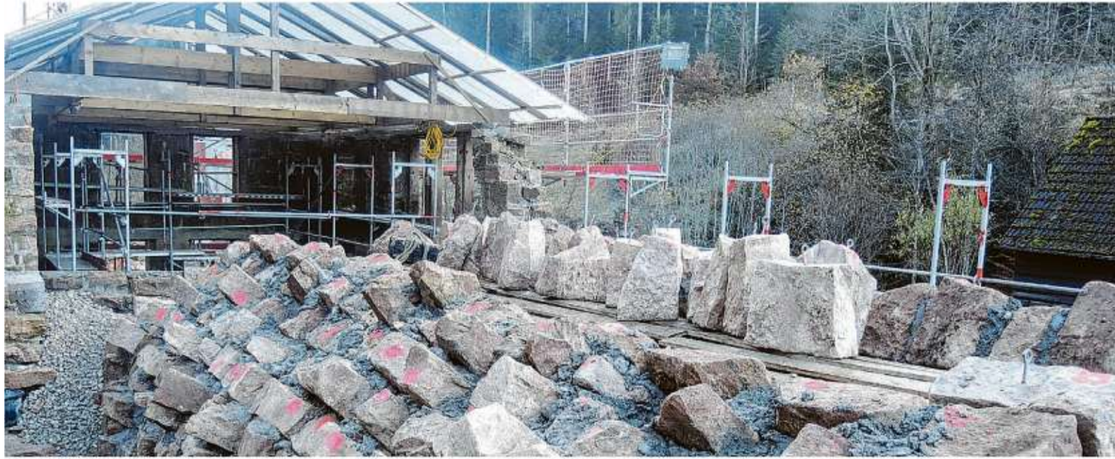
Das alte Rußgewölbe ist weitgehend fertiggestellt. Sämtliche Steinblöcke sind ortsgenau eingebaut. Rücklings zeigt sich die gewölbe-typische Igelstachel-Struktur. Nach dem Aufbau der Außenmauern wird der Gewölbebogen von oben nach alter Machart mit Steinmaterial verfüllt und eingebettet. Foto: Siegfried Schmidt
