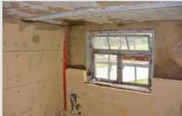
Abb. 7.11: Innenansicht des denkmalgeschützten Gebäudes mit Innendämmung aus Holzfaserplatten mit weiterem Aufbau mit Lehm
