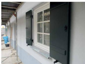
Aufgrund der erhaltenswerten historischen Stuckelemente im Innenbereich wurde bewusst keine Innendämmung gewählt. Dementsprechend fiel die Wahl auf einen Dämmputz im Außenbereich.
