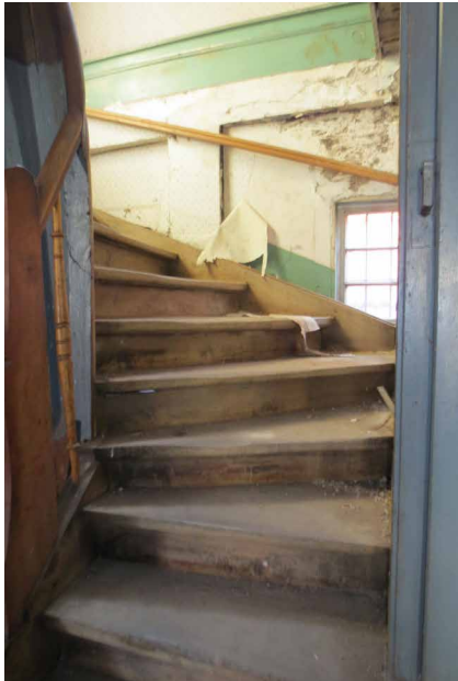
Blick ins historische Treppenhaus vom OG ins DG (Gebäudeteil Nr. 4)
