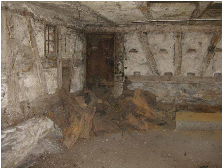
Innen sichtbare Fachwerkwand im Erdgeschoss Haus Nr. 8 aus Eiche; Decke über EG als Lehmwickeldecke (im Haus Nr. 8)
