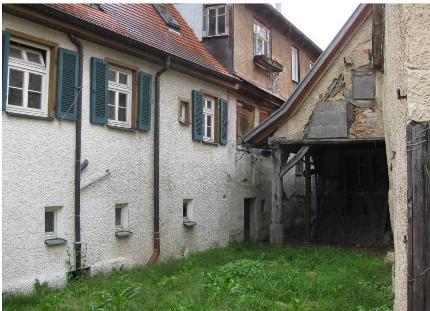
Enge Nachbarbebauung (Gebäude links ist Haus Nr. 4)
