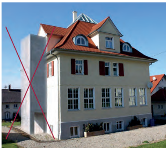
Negativ: Eine externe Erschließung aus massiven Baumaterialien verdeckt die sehr gut erhaltene Außenfassade.
